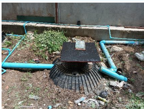
รูปที่ 3-22 ถังบำบัดสำเร็จรูป บริเวณพื้นที่ก่อสร้าง
